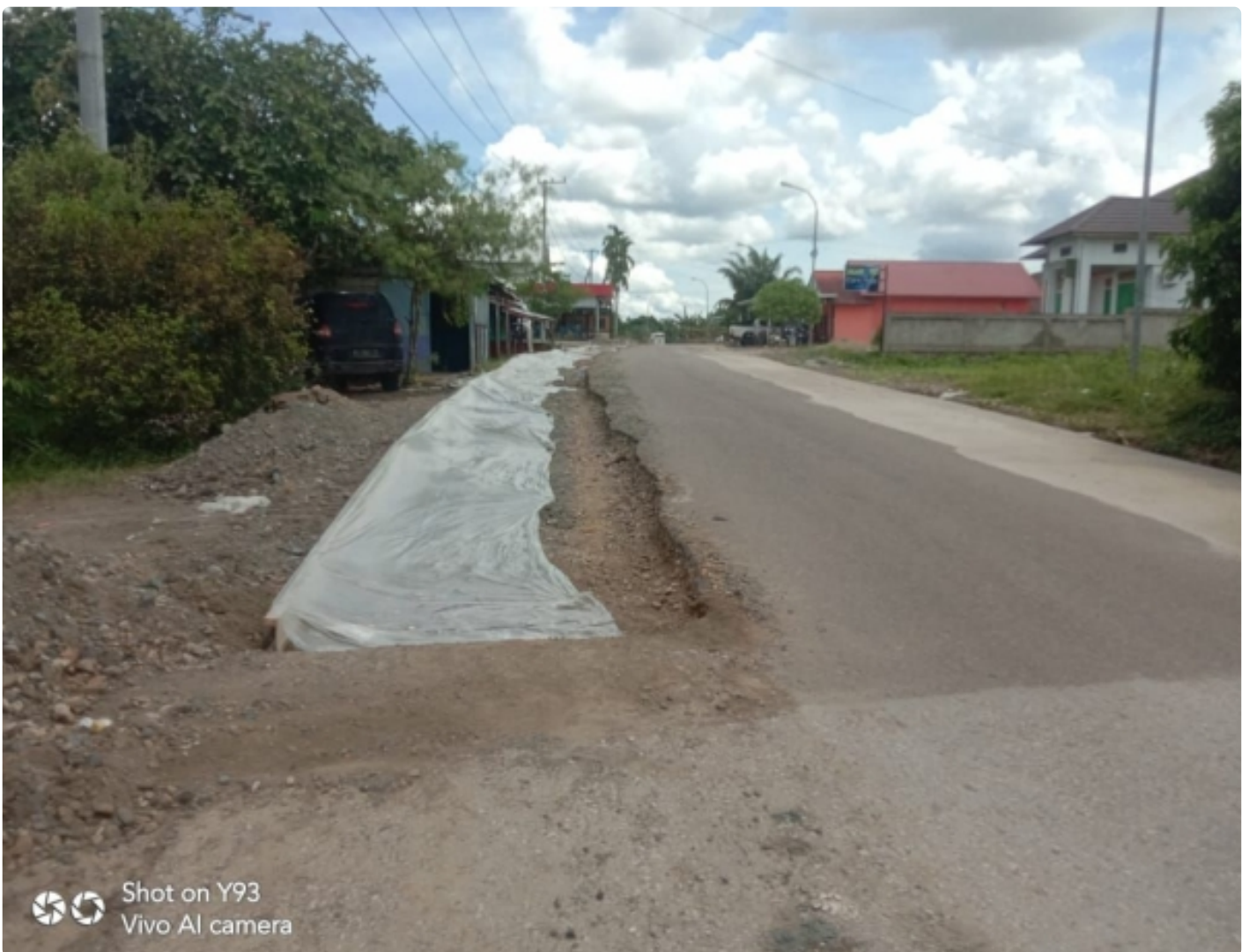
Caption : Salah satu proyek semenissi yang dikerjakan tanpa papan plang pengumuman
